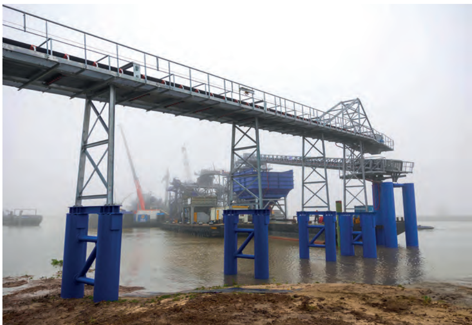
Afb. 2 De transportbanden leiden naar een ontvangsbunker op een drijvend ponton.
